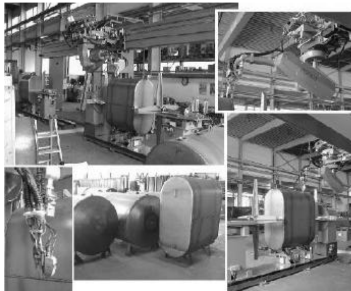
Bild 28 Einsatz eines Lasersensors beim Schweißen von Öltanks, Quelle: CLOOS, Haiger
