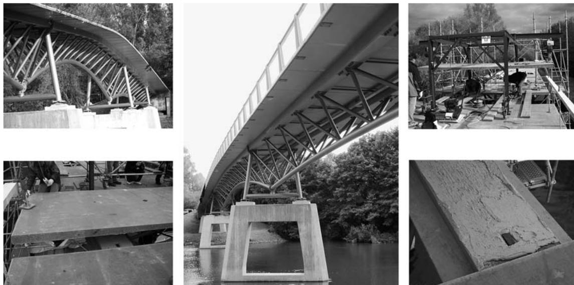
**Bild 3** - Kasseler Gärtnersplatzbrücke im Bau (ca. 10 cm dicke UHPC Deckenplatten wurden ausschließlich mit einem 2K-Epoxidharzklebstoff auf die UHPC Obergurte geklebt)
